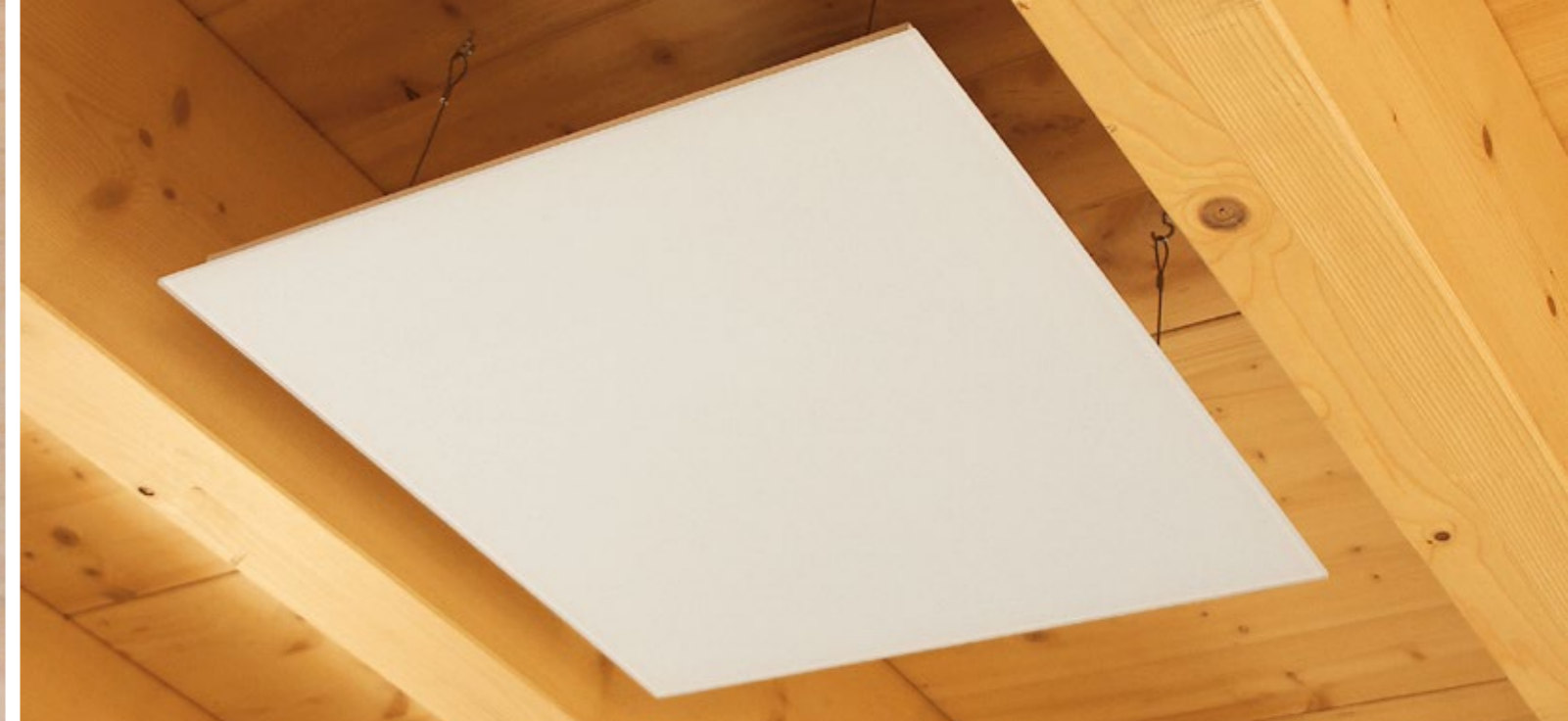
VH-Heizelement von der Decke abgehängt.
