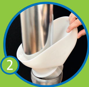
Wabensieb parallel zum Rohr halten.
