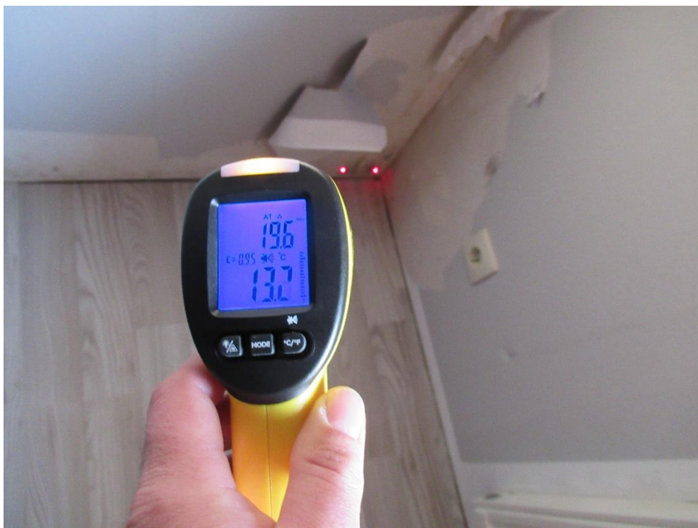
Exemplarisches Bild aus einem Auftrag: 19,6 °C Lufttemperatur, 13,2 °C Wandtemperatur
