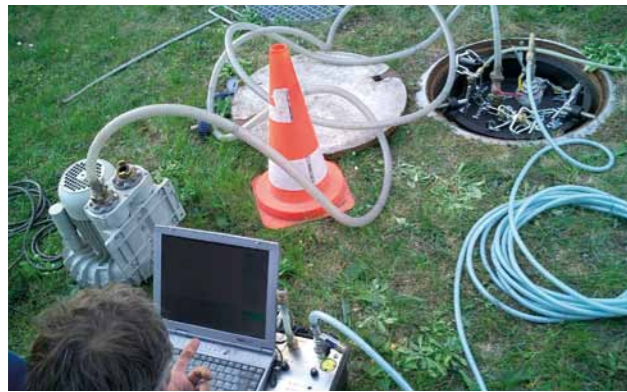
Schachtprüfung mit Vakuum
