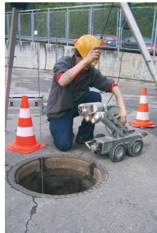
Vorbereitung zum Einsatz eines Kamerawagens
