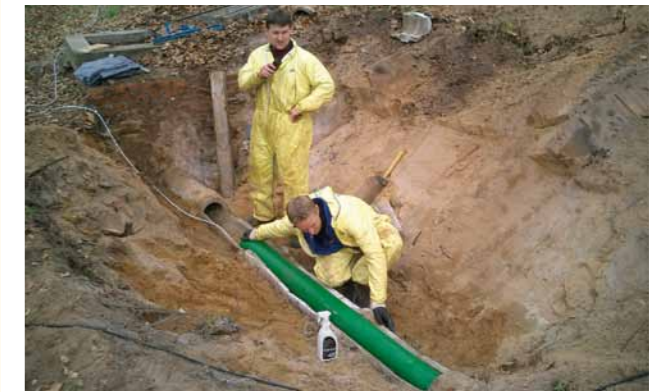
Vorbereitung für die Rohrreparatur
