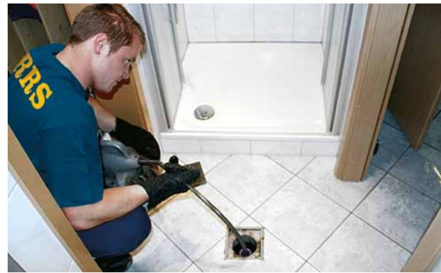
Verstopfungsbeseitigung im Sanitärbereich
