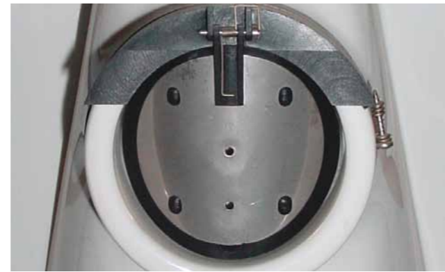
Toilettenanschluss mit Rattstop Schutzklappe
