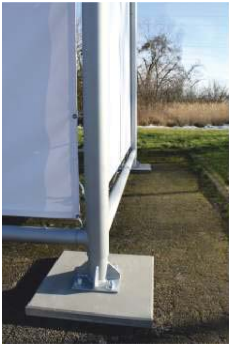
Stahlstandpfosten mit Knotenblechen und Sockelplatte, verzinkt.
