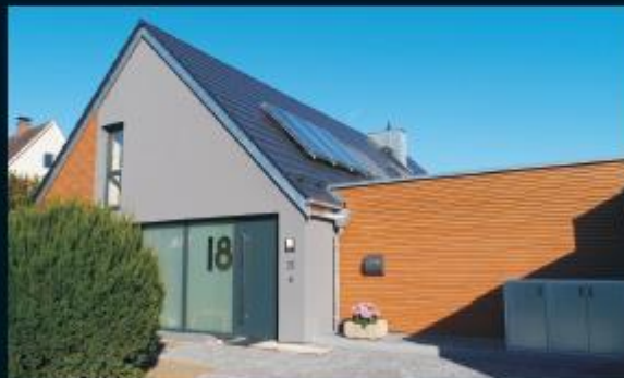
Dachsanierung mit Anbau
