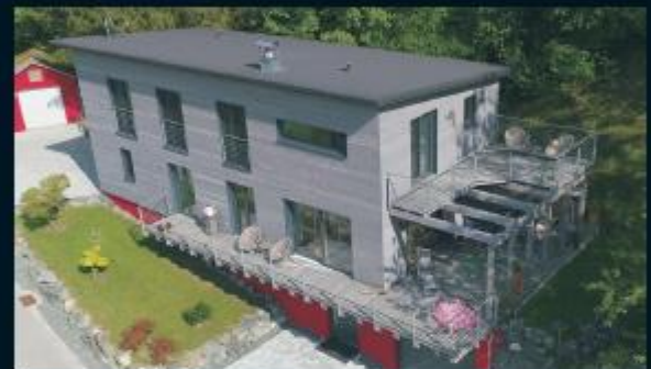
Holzhaus im Raum Ammersee
