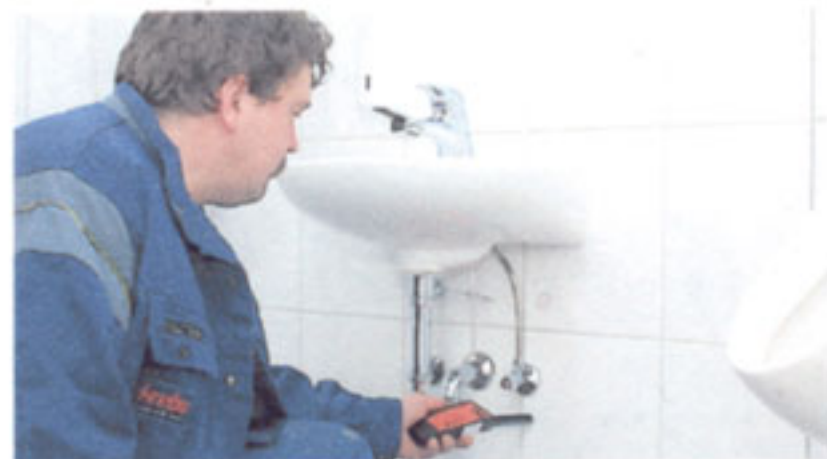
Sucht Lecks: Sanitär- und Heizungsinstallateur Uwe Kutsch.
