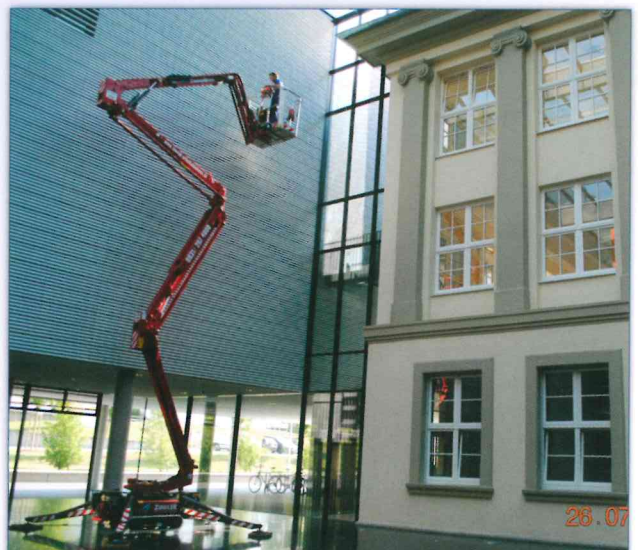
Dann groß ! Ausgefahren bis zu einer Höhe von 21 Metern.
