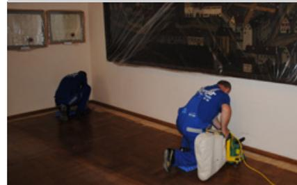
Abgenutzte Pflegefilme werden entweder vollflächig oder partiell nach der Cleanermethode ausgebessert.
