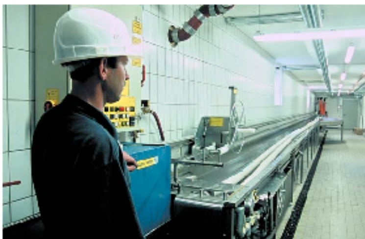
Prüfung von Schläuchen in der Werkstatt
