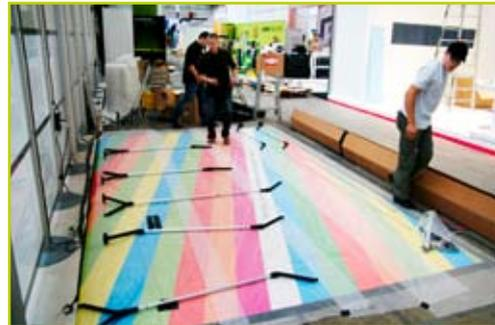
Die stufenlos verstellbaren Teleskopstangen geben der Rückwand den notwendigen Halt.
