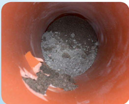
Scherbenbildung in einer Steinzeugleitung
