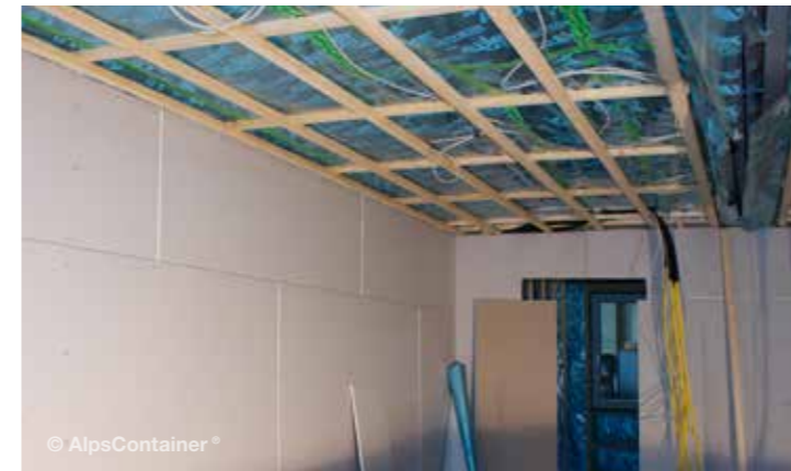
Dämmung/Isolierung und Innenauskleidung
