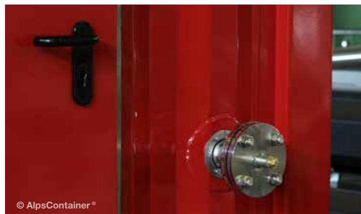
Wasserdichte Rohrdurchführungen und Medienanschlusskasten
