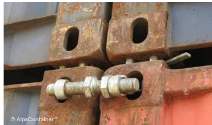
Stapelsicherungen und Verbindungselemente zum sicheren Stapeln und Verbinden mehrerer Container
